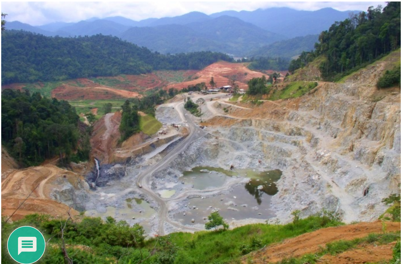
Tapak pembinaan Empangan Sungai Selangor adalah tanah adat Orang Asli Temuan Gerachi dan Peretak – CAROL YONG
